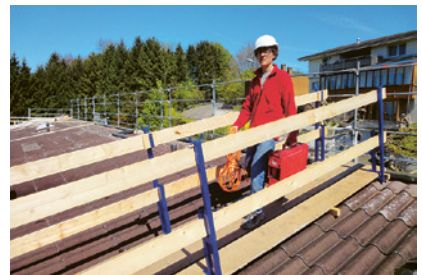
3 Se le superfici non sono resistenti alla rottura, usare una passerella.
