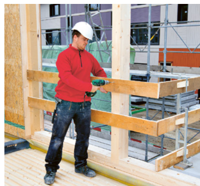
3 Apertura nella parete messa in sicurezza con una protezione laterale
