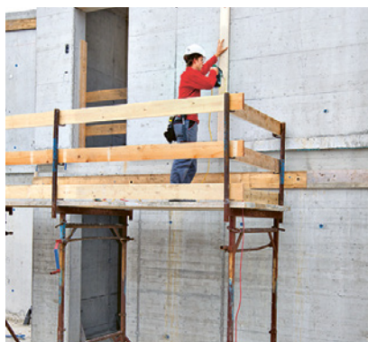
2 Ponteggio a cavalletto con protezione laterale corretta
