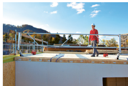
3 Protezione laterale mobile sui lati a rischio caduta a bordo tetto
