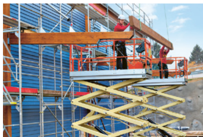
2 Montaggio di travi con piattaforma di lavoro elevabile
