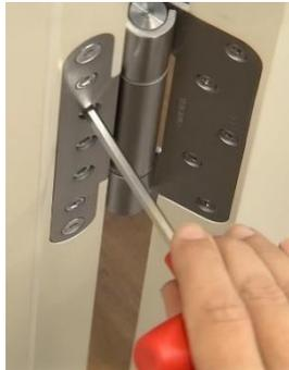
Bei Objektbändern sind die vom Hersteller angegebenen Anzugsdrehmomente unbedingt einzuhalten. Dafür ist die Verwendung eines Drehmomentschlüssels unerlässlich.
